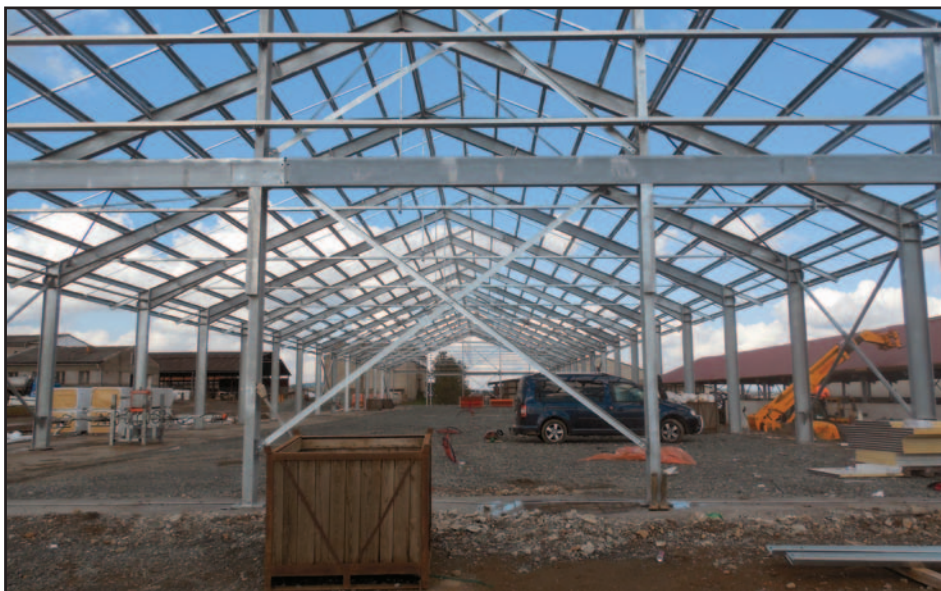
Stavba nové haly pro 127 kusů dobytka.
